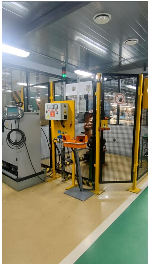
Вход в зону работы робота через сервисную дверь
